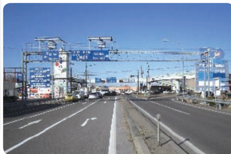
須坂市の玄関口 須坂長野東インターチェンジ出口付近
